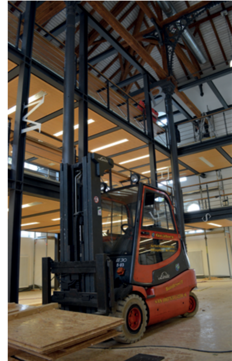
Ein Gabelstapler mitten in der Bibliothek? Während der vorlesungsfreien Zeit waren mehr Werkzeuge und Baufahrzeuge als Bücher in dem Gebäude.
